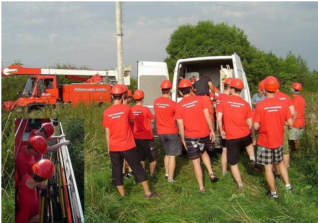
Prohlídka montážního vozidla a vybavení montážní čety pro práci pod napětím
