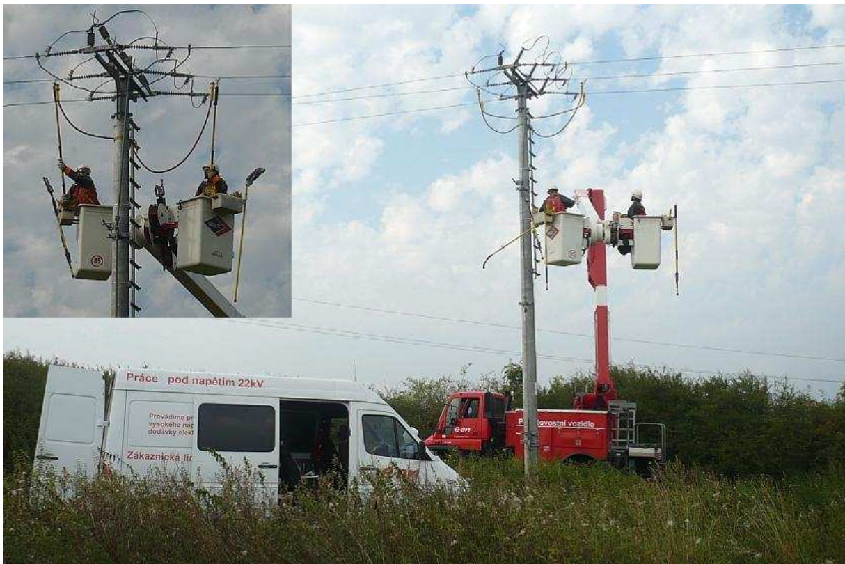
Ukázka práce pod napětím na úsečnicku venkovní linky 22 kV
