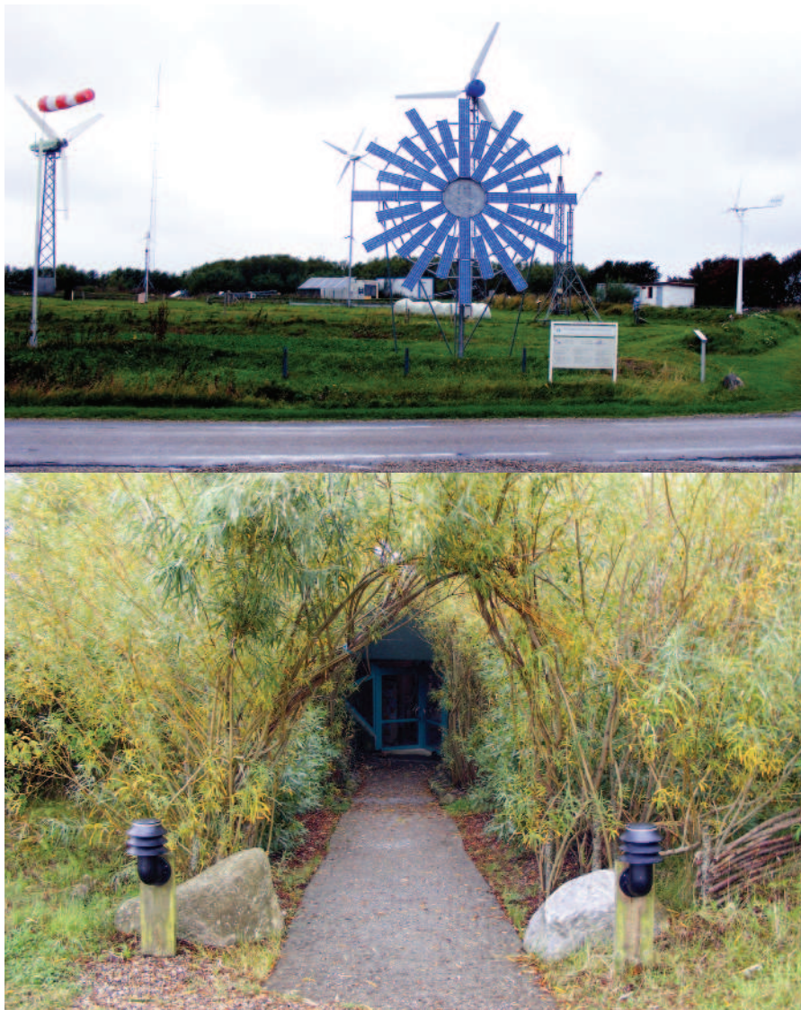
Folkcenter Hurup – nahoře areál výzkumu využívání energie větru, dole vchod do kongresového centra.
